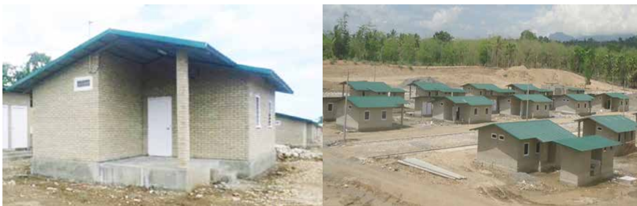
Progresso da construção das infraestruturas de apoio à reabilitação do aeroporto do Suai
