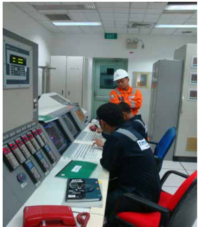
Destacamento na PT. Badak NGL, Indonésia
