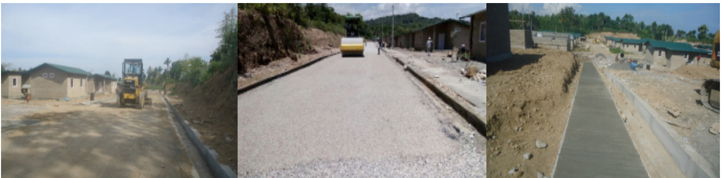
De cima para baixo, da esquerda para a direita: Novas habitações da comunidade afetada; Restantes habitações em construção; Via rodoviária de acesso; Sistema de drenagem
