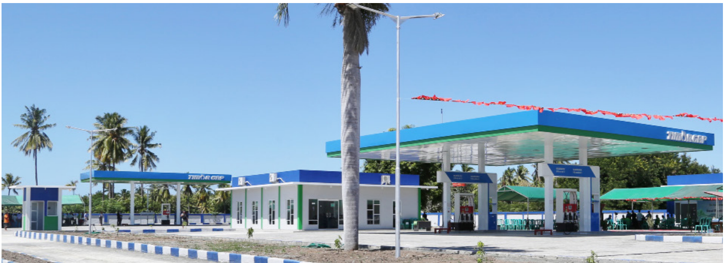
Posto de Abastecimento de Combustível do Suai
