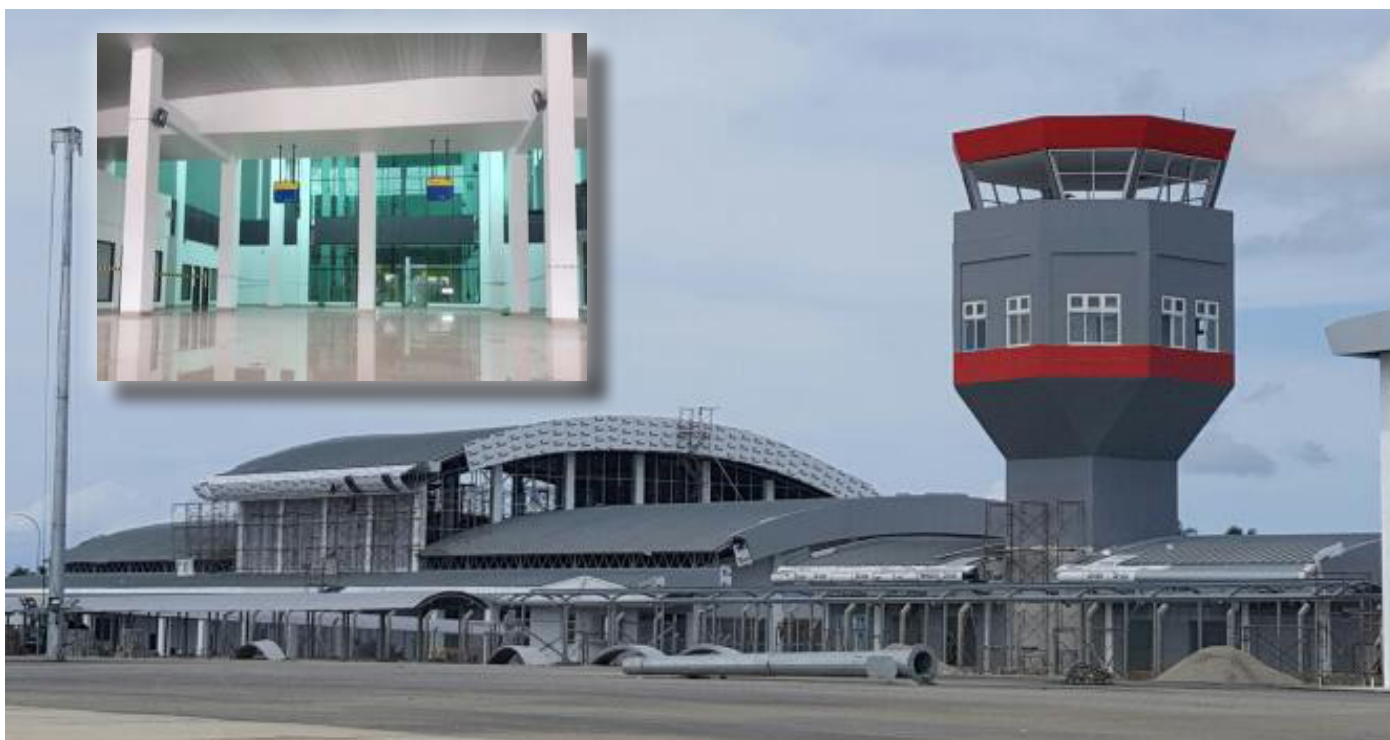
Figura 5-4: Aeroporto do Suai em 2017 com Torre de Controlo de Trafego Aéreo e Entrada Principal
