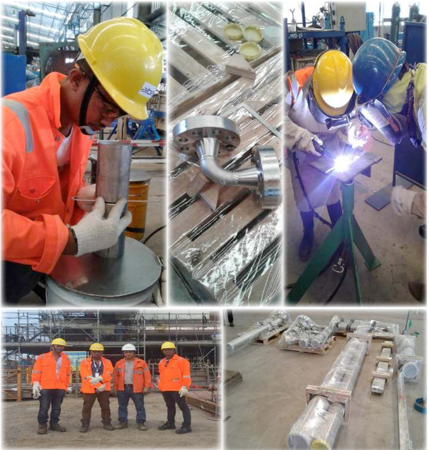
Figura 3-5: Formação Profissional na Deeline Aibel, Tailândia; Tubos & Estruturas Finalizadas
