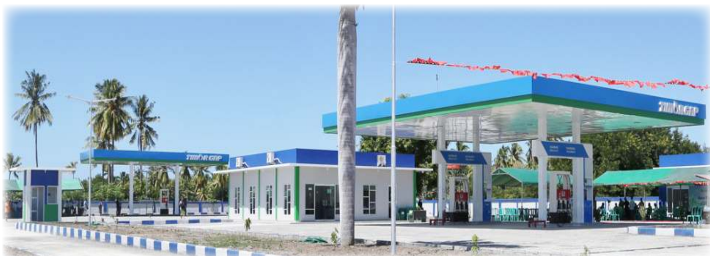
Figura 3-2 : Posto de Abastecimento de Combustível da TIMOR GAP no Suai
