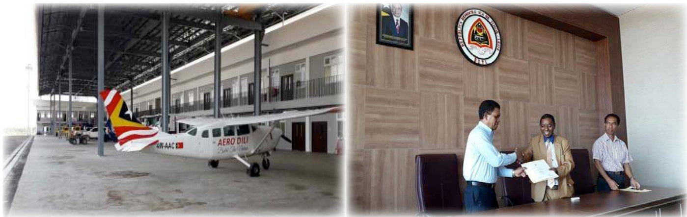
Figura 4-7: Hangar de helicópteros com capacidade para acomodar 4 helicópteros e uma ponte rolante junto à área de manutenção, com 106.8m de comprimento e 22m de largura (esquerda); Entrega parcial do Aeroporto do Suai à ANATL (direita)
