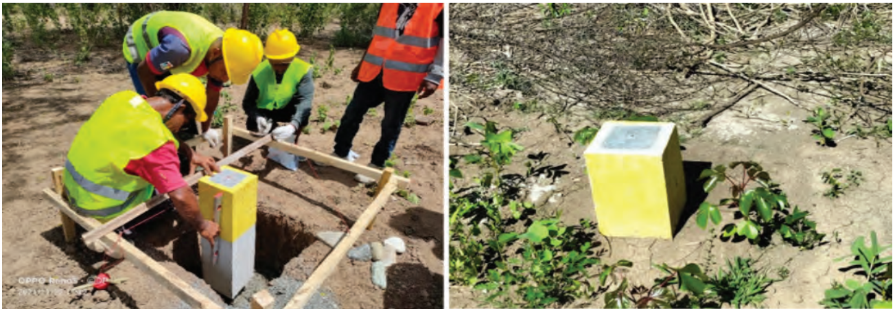
Figura 4-8: Progresso da instalação dos marcos de referência da SSB
