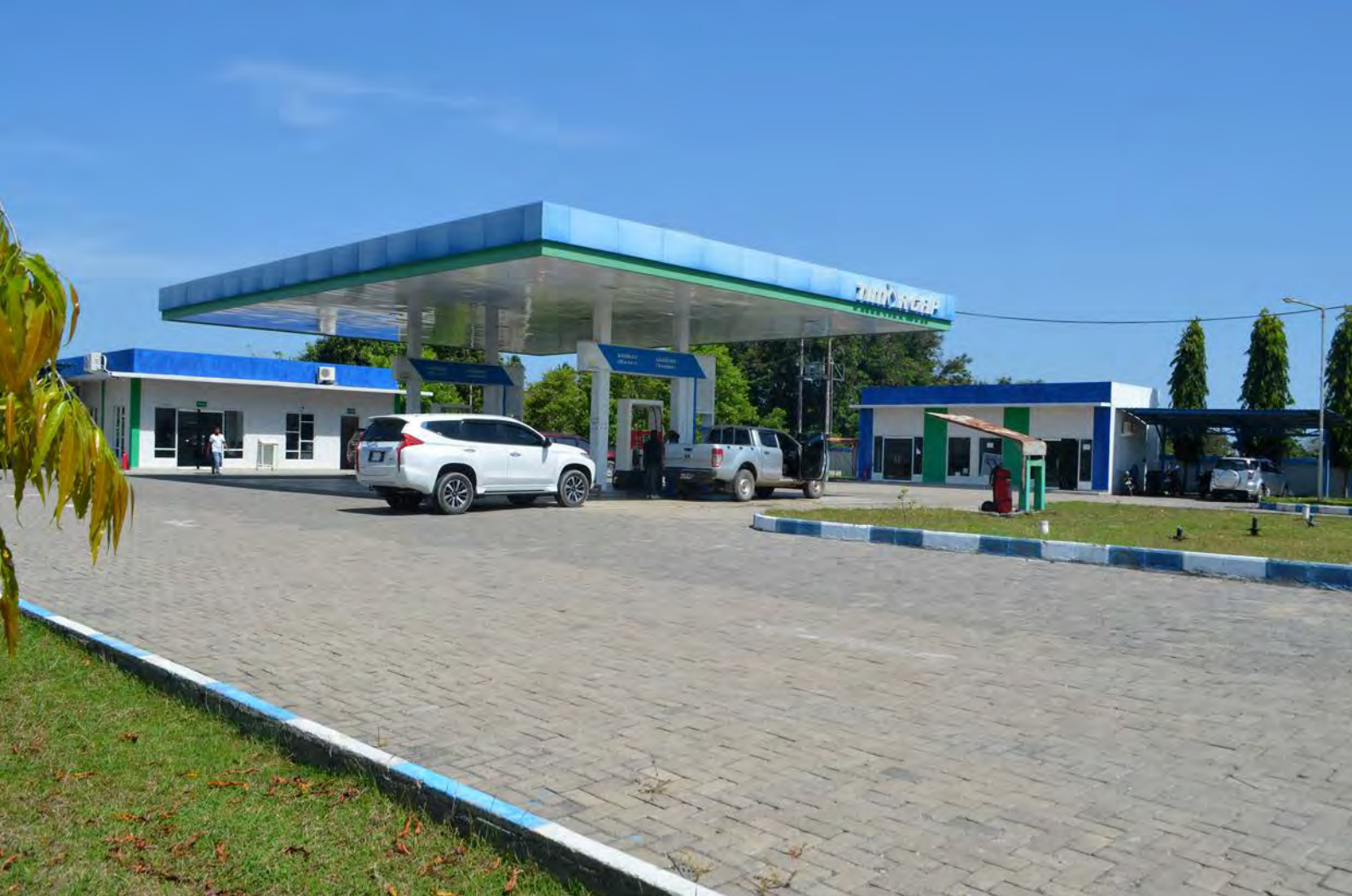
Figura 3-8: Posto de abastecimento de combustível da TIMOR GAP no Suai
